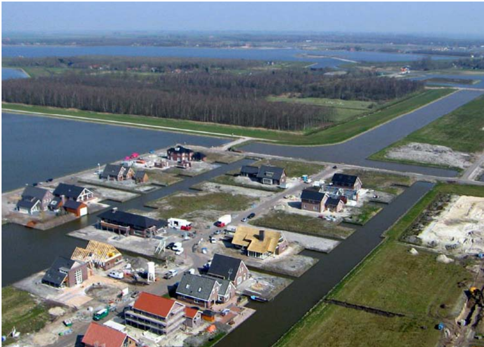
Blauwestad ligt in Oost-Groningen. Men wil het gebied een economische impuls geven met de aanleg van een meer, natuurgebieden, toeristisch recreatieve voorzieningen, bouw van woningen en met het aantrekken van mensen van elders die hier hun geld komen besteden.
