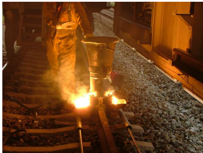
Figuur 3.3 Raillassen: meestal nachtwerk
