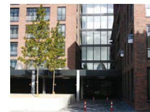
Uit de windtunnel bleek windhinder mogelijk bij de entree van de Holland in Tilburg, waarna een luifel werd ingepast.
