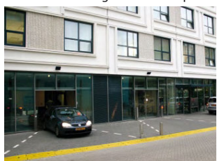
De Witte Keizer in Rotterdam heeft een compacte automatische parkeergarage die verkeersruimte tot een minimum beperkt.
