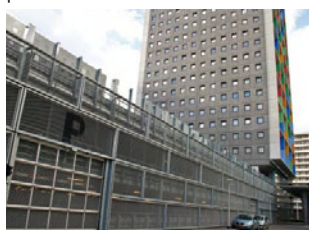
De achterkant van Westpoint wordt gedomineerd door een parkeergarage op het maaiveld.
