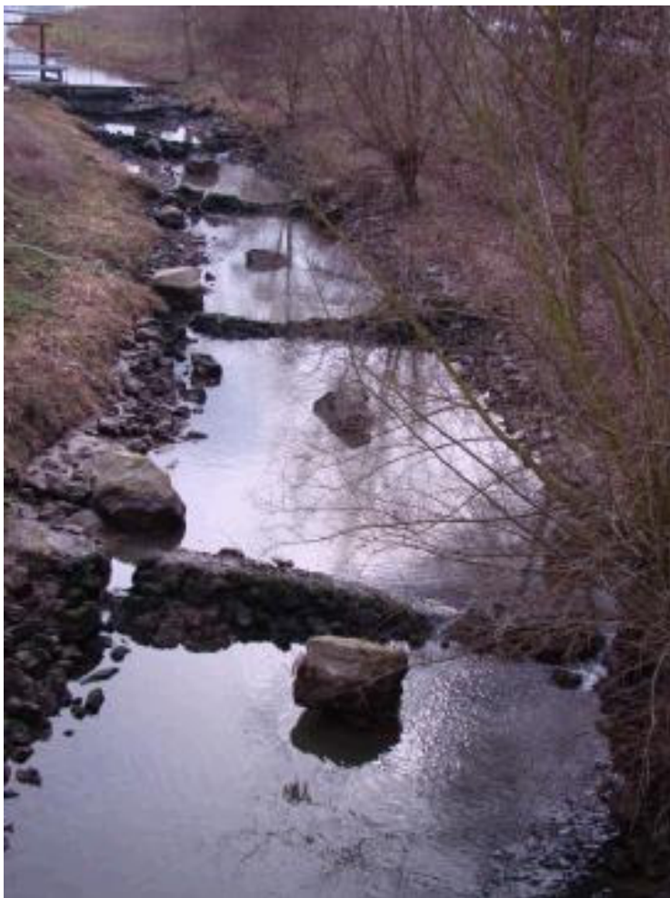
Figuur 2. Foto van de bekkenvistrap bij Roermond, buiten bedrijf.
