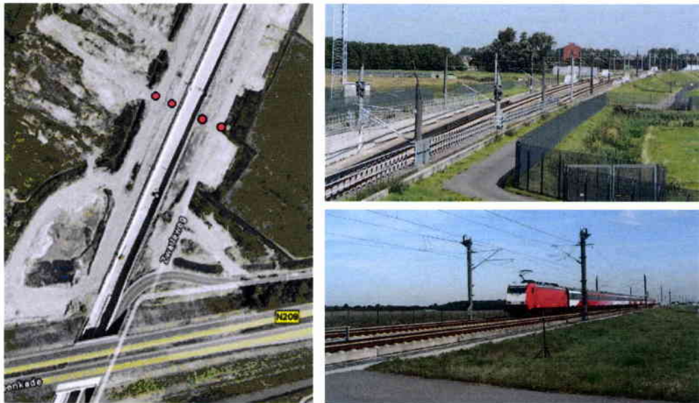
Figuur 2.1: De meetlocatie Schiebroek. De foto links is een luchtfoto in de situatie toen het spoor nog in aanbouw was. De rode punten in deze foto zijn de posities van de microfoons. De foto's rechts tonen het zicht richting noorden (Berkel en Rodenrijs/Amsterdam).
