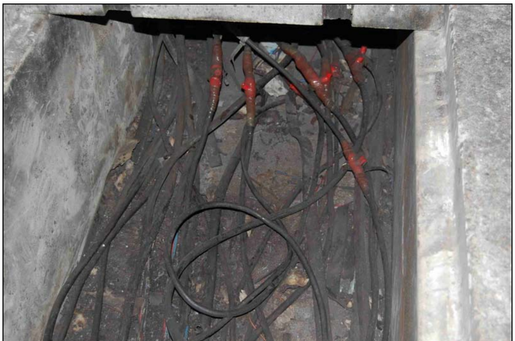
Afbeelding 4: De herstelde kabels in de kabelgoot onder het voetpad.
