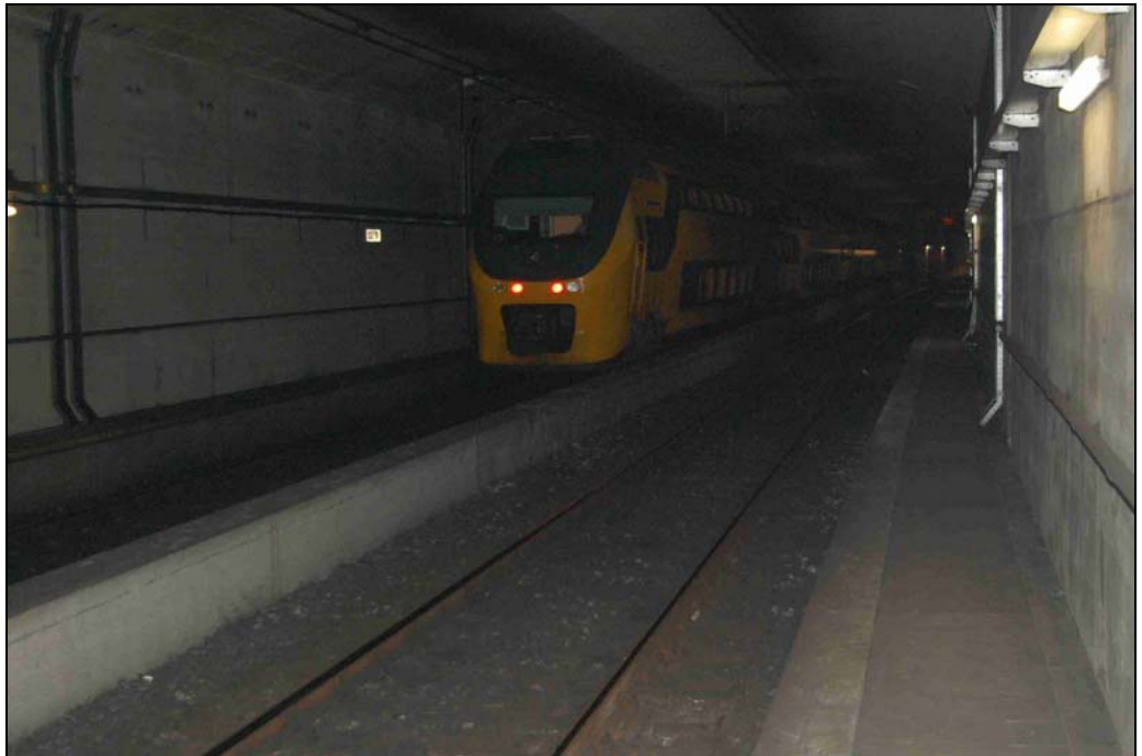
Afbeelding 3: Rechts bevindt zich het looppad in de tunnel waaronder zich het kabelbed bevindt.
