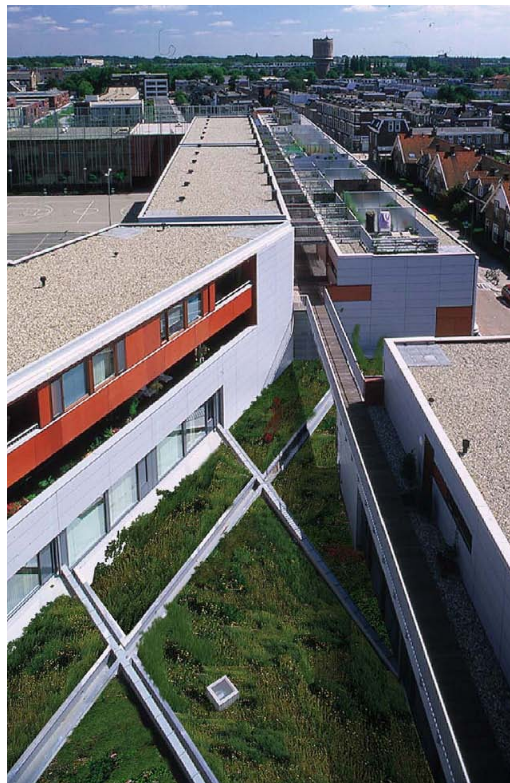
Tangram, twee kantoorgebouwen in het Arenapark, Hilversum 2003.
