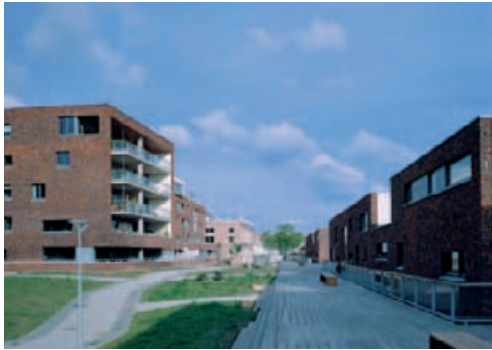
Vondelparc, Utrecht - Project 29
