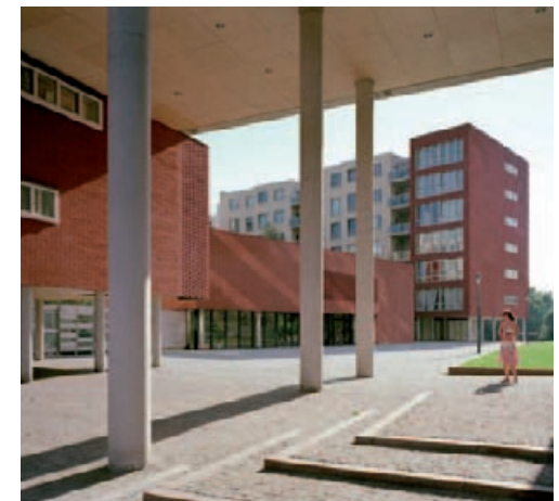
Brede poort als toegang van de collectieve ruimte, Olympisch Kwartier, Amsterdam
