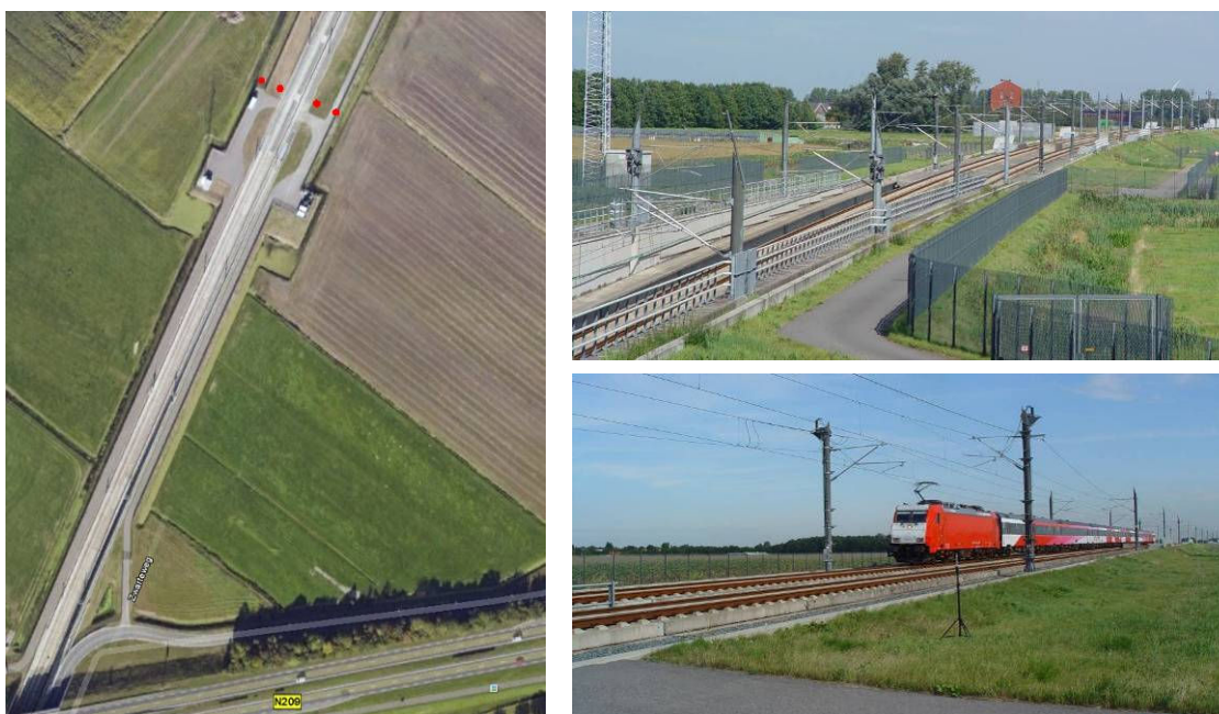
Figuur 2.1: De meetlocatie Schiebroek. De rode punten in de luchtfoto links zijn de posities van de microfoons. De foto's rechts tonen het zicht richting noorden (Berkel en Rodenrijs/Amsterdam). Rechtsonder de Traxx-locomotief met Prio-rijtuigen.
