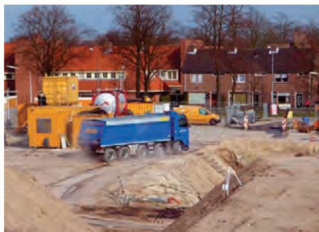
Sanering van het voormalige REGEV-gasfabriekterrein in Hilversum – grondtransport
