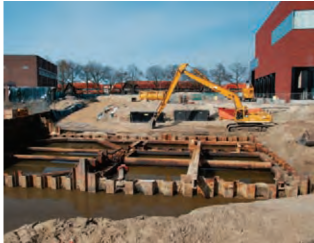
Sanering van het voormalige REGEV-gasfabriekterrein in Hilversum – plaats van de put met damwanden waar tot op 17 meter diepte de vervuiling nat werd ontgraven
