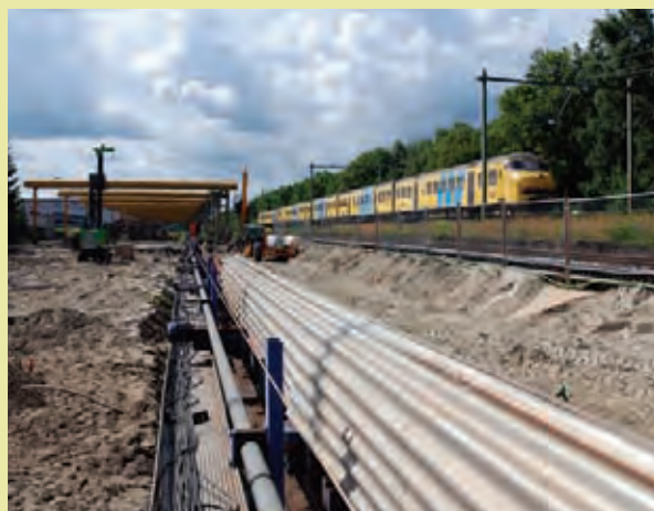
Aanleg saneringssysteem langs het spoor (Foto: SBNS)
