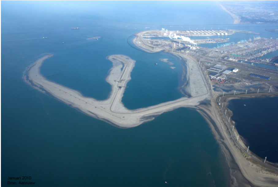
Figuur 2: Luchtfoto Maasvlakte 2 in aanleg - opgenomen januari 2010
