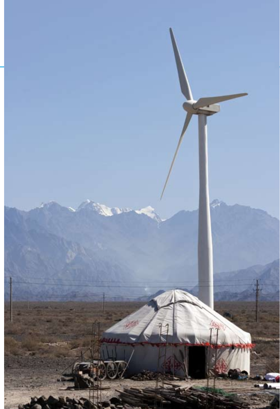
China en India kunnen hun energievoorziening meteen een stuk duurzamer maken
