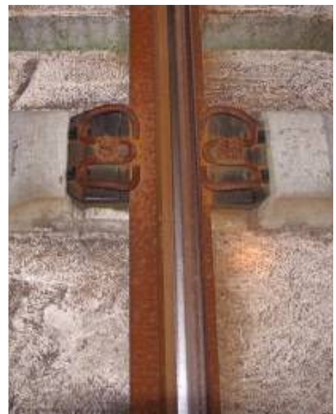
Oostspoor buitenrail ZBH
