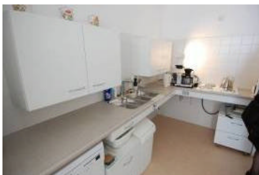
Aangepast onderrijdbaar keukenblok
