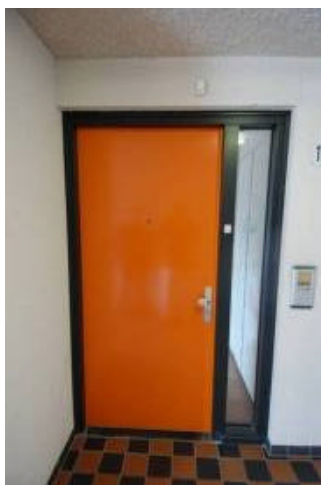
Op afstand bedienbare toegangsdeur tot woning
