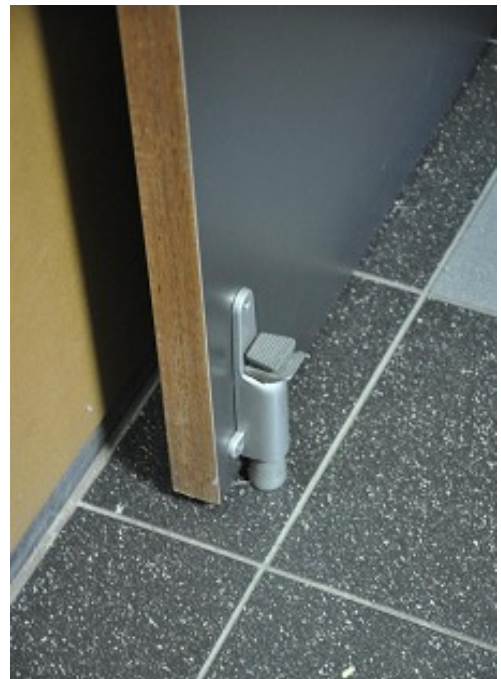
Voorbeelden van vastgezette deuren in brandwerende scheidings.
