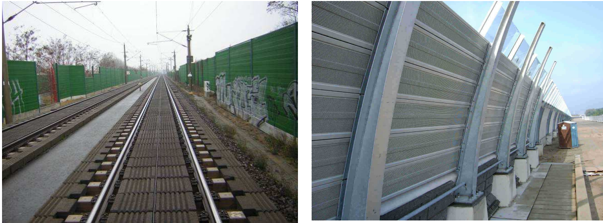
Figuur 5.4 aangebrachte geluidsabsorberende elementen tussen en naast de sporen en op de wanden.
