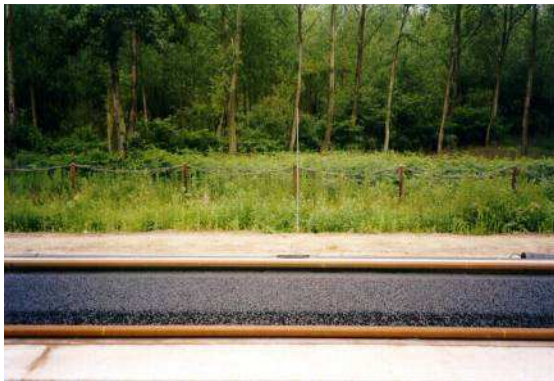
Figuur 5.2 Absorberend asfalt tussen de rails
