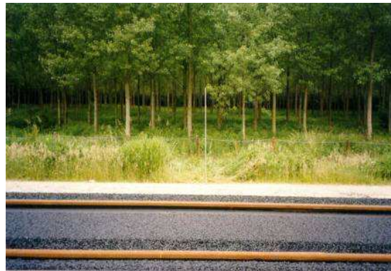
Figuur 5.3 Absorberend asfalt tussen en naast de rails
