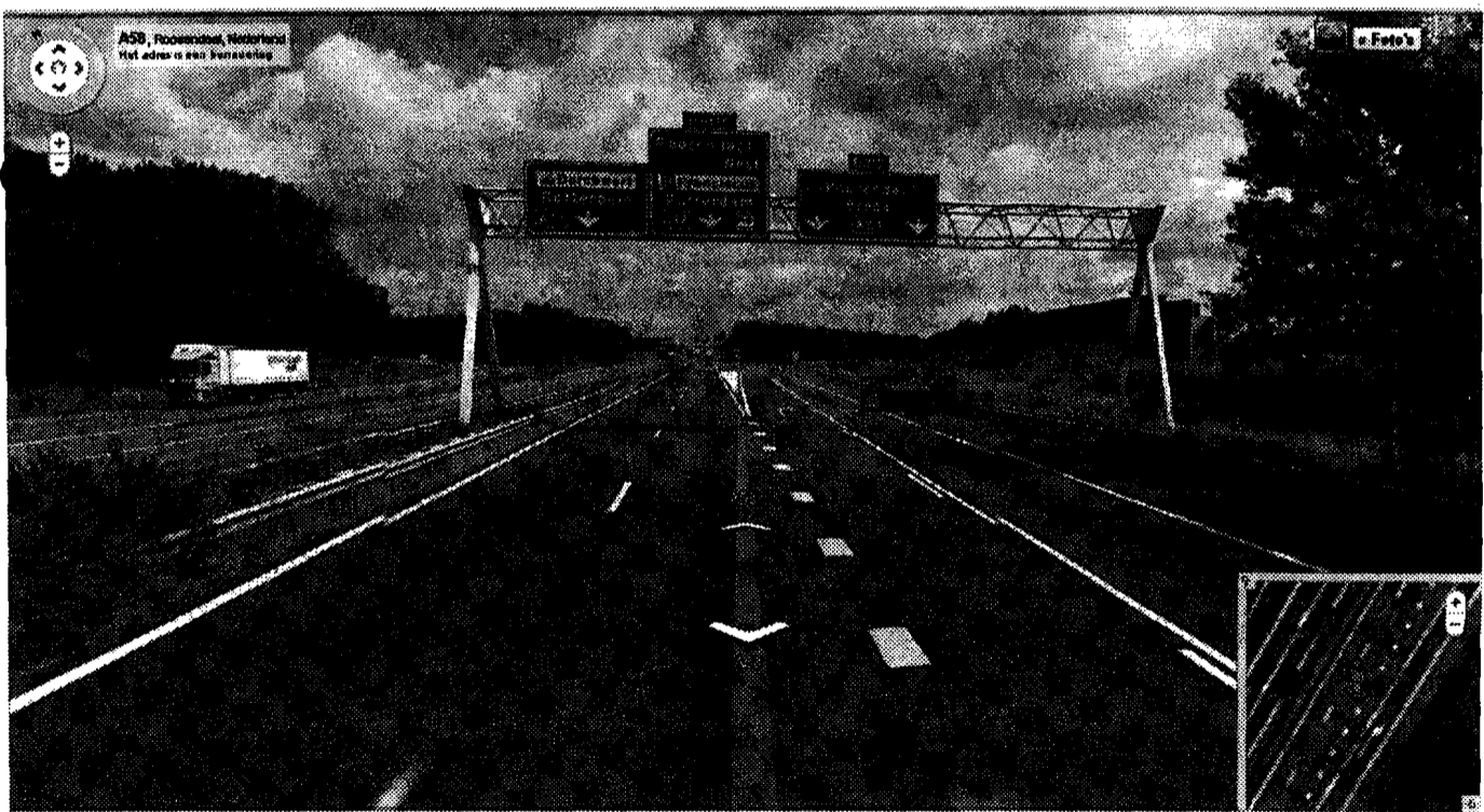
Exitlocatie zuidbaan: A58 hmp 95,05 Li
