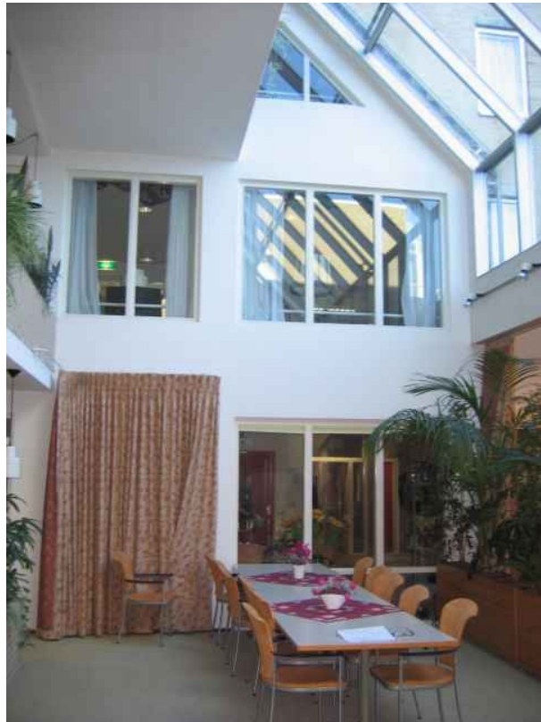
Foto 1: Te grote oppervlakte draadglas in brandwerende scheiding.
