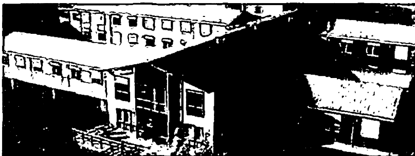
Afbeelding 1: Gemeentekantoor De Waard in Bleskensgraaf (tijdelijke huisvesting)
