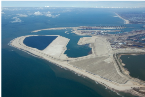
Foto: Luchtfoto Maasvlakte 2 in aanleg (juni 2012)
