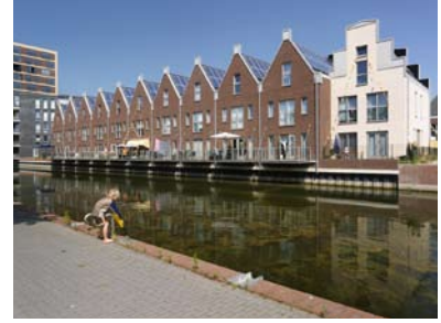
Nieuwbouw en Herstructurering
