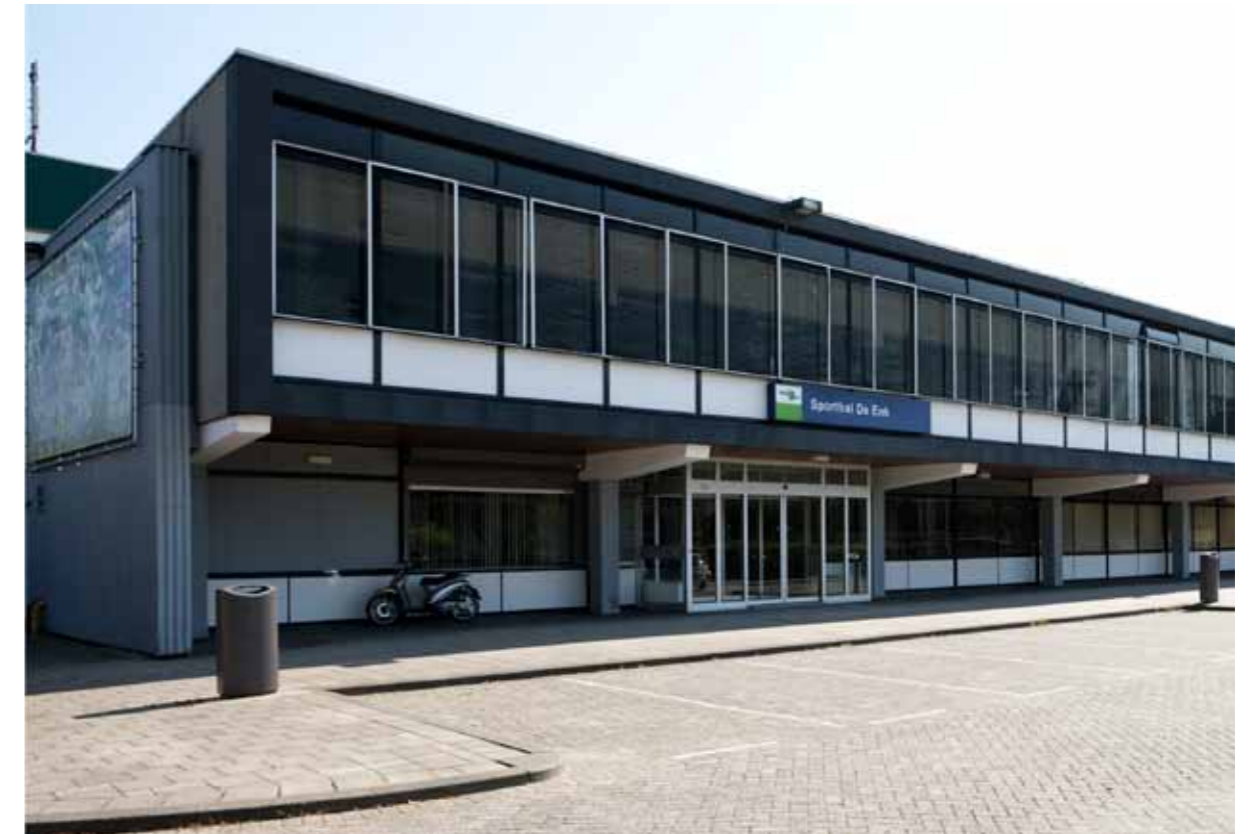
Entrance to De Enk Sports Hall / Entrée du complexe sportif De Enk
