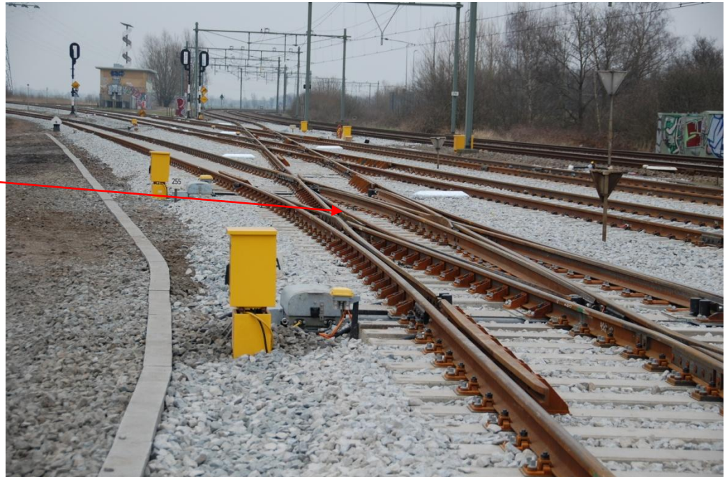
Afbeelding 5: te zien is het vernieuwde wisselcomplex op het emplacement Groningen losplaats. De pijl wijst naar wissel 255.
