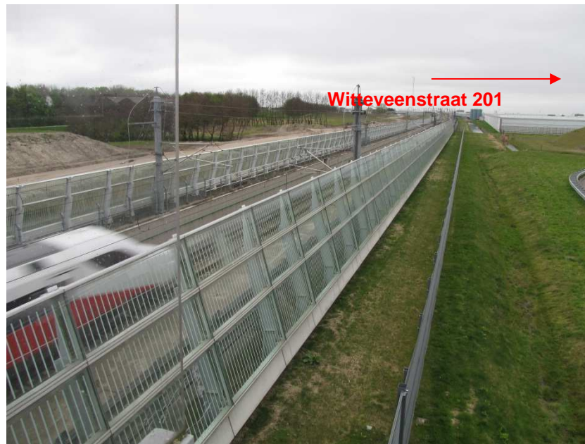
Figuur 7 Overzicht van het HSL spoor ter hoogte van de Witteveenstraat 201.
