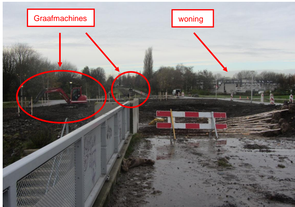
Figuur 23 Foto werkzaamheden in omgeving van woning
