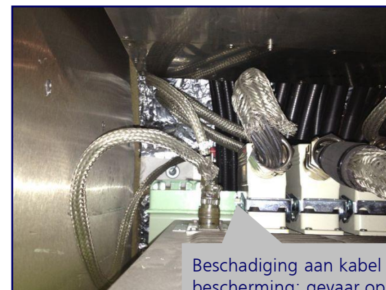
Onbeschermde elektronische contacten
