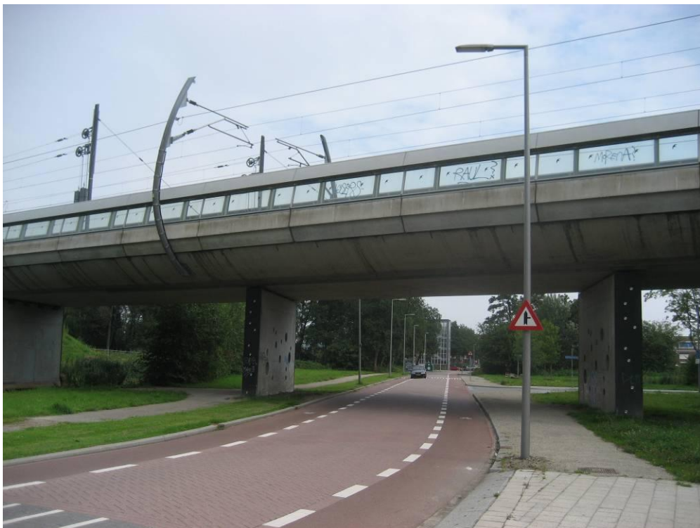
Figuur 2 Verlegde Havenspoorlijn over de Krabbendijkestraat
