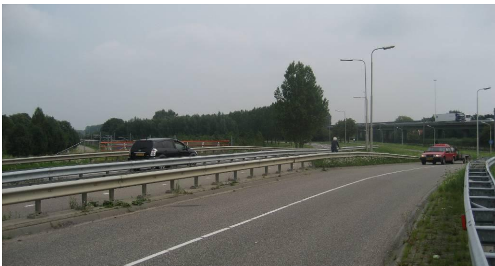
Figuur 9 Betuweroute in half verdiepte open bakken verhoogde A15 op de achtergrond. De zwarte auto rijdt op de N216, de rode op de aansluiting van de Schelluinesebrug
