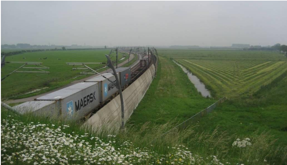
Figuur 6 Betuweroute gezien van de Zwijnskade in oostelijke richting
