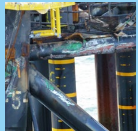
Foto van de omgeving van poot A1, de schade is duidelijk zichtbaar (Bron: NAM)
