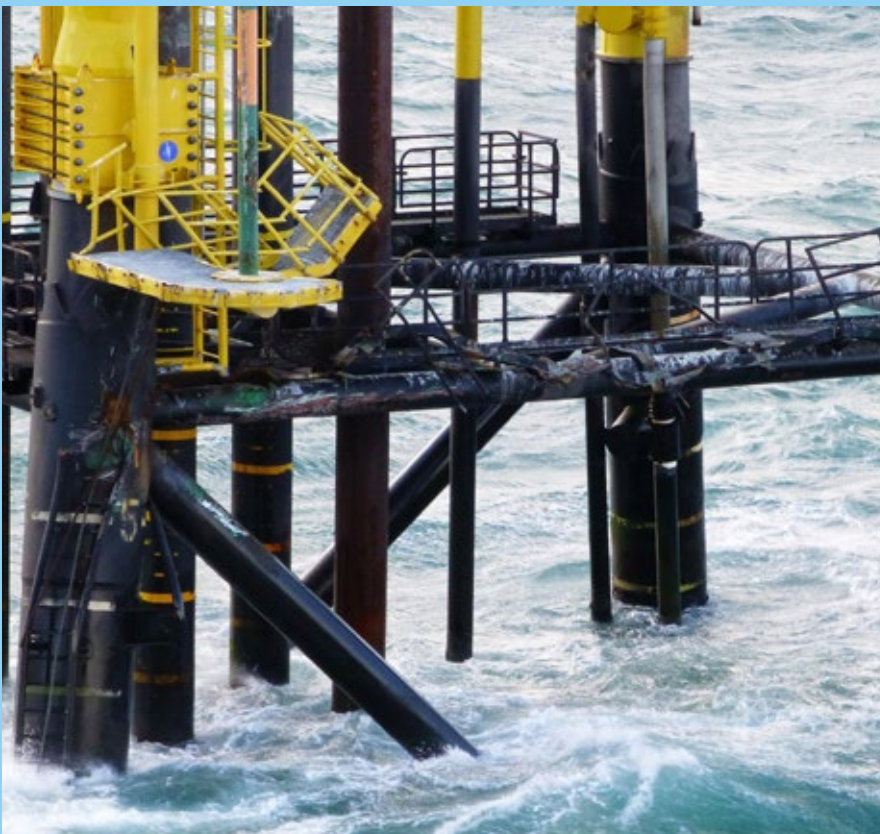
Foto van de omgeving van poot A1, de schade is duidelijk zichtbaar (Bron: NAM)
