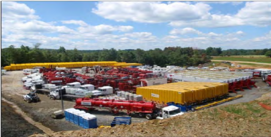
Afbeelding 2.11. Opstelling van fraccen materieel [ref. 2.]
