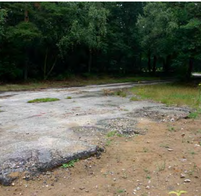
Locatie verwijderde bunker
