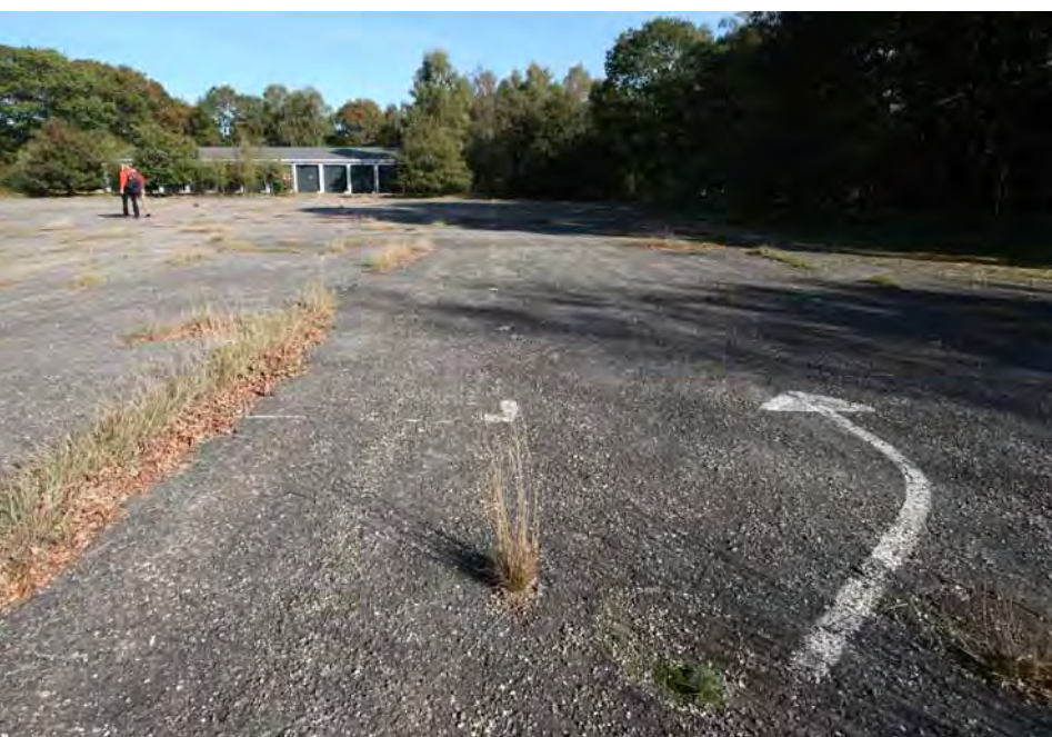
26 Asfaltvlakte op het oude terrein
