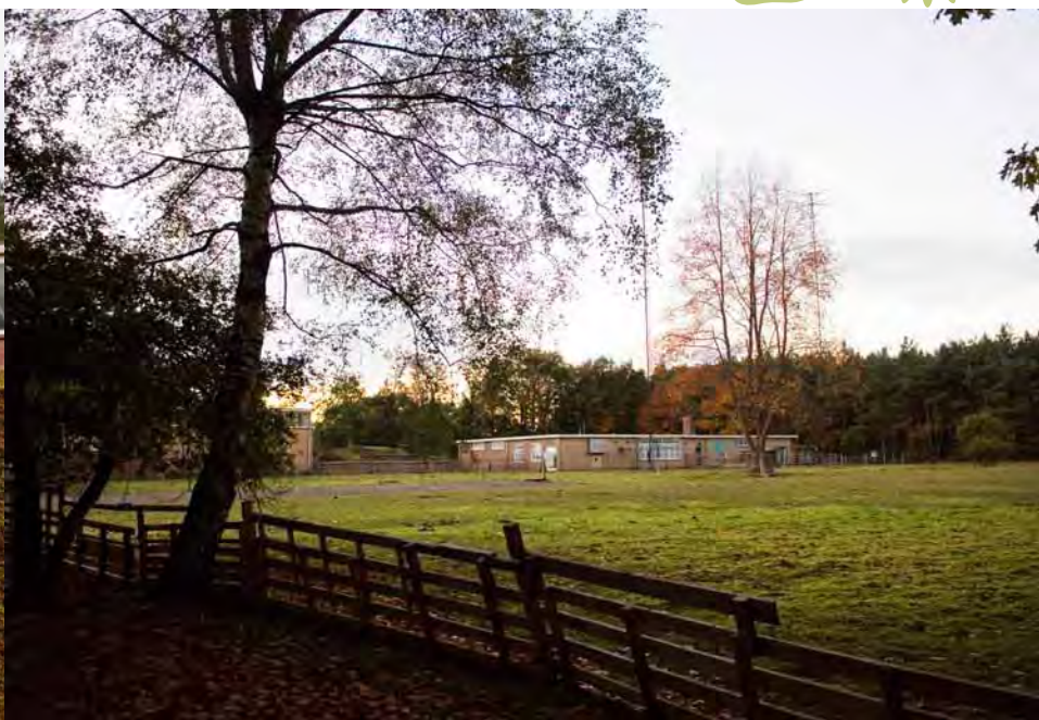
Zicht op het terrein
