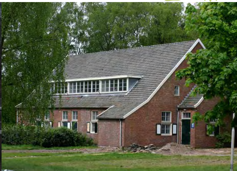
Gecamoufleerde bunkerwoning voor de renovatie
