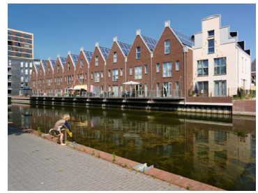
Nieuwbouw en Herstructurering
