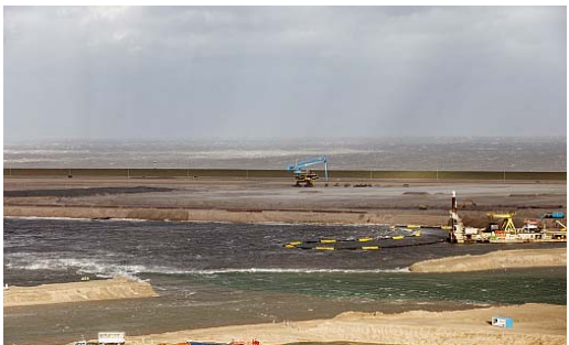
Foto: Dijkdoorbraak Yangtzehaven (november 2012)
