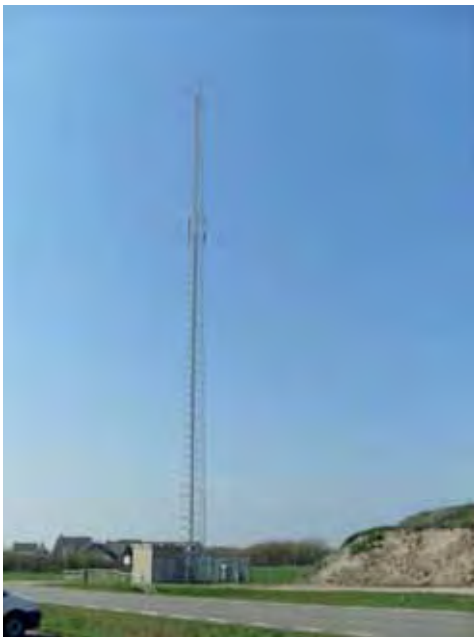
Figuur 3.28 C2000 mast (voorbeeld)
