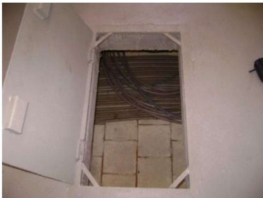
Foto 7.2 Kruipruimte onder de vloer van het veldhuisje
