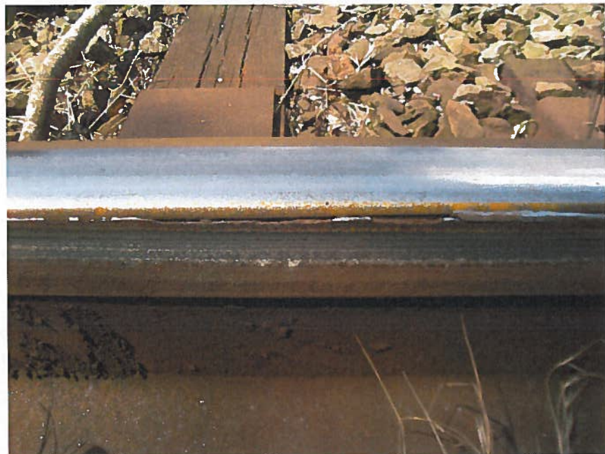
Figuur 19. Uitbrokkeling tong in Zeeuws Vlaanderen
