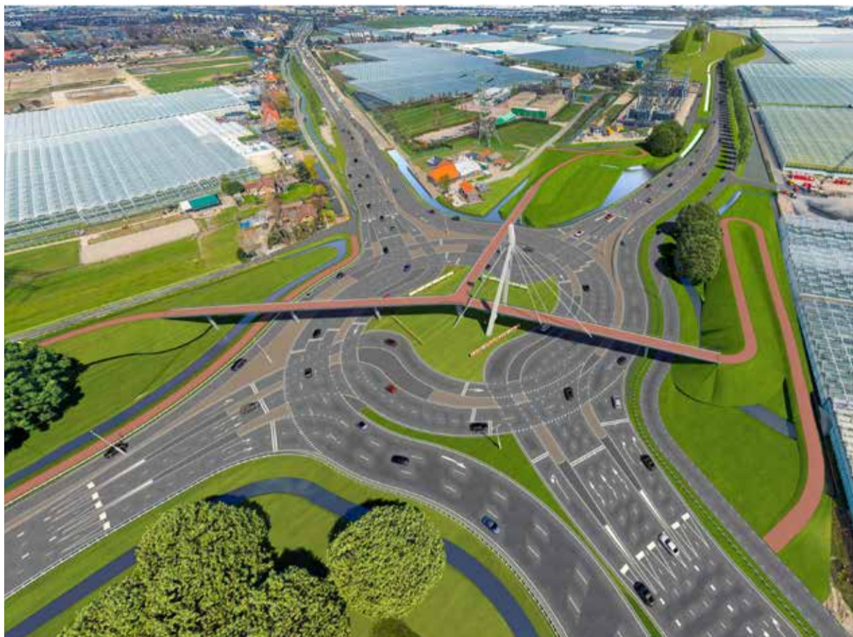
Dit fietsviaduct komt over het nog aan te leggen Vlietpolderplein in gemeente Westland. Met het fietsviaduct herstellen en optimaliseren we de oude fietsverbindingen en vergroten we de fietsveiligheid. Het fietsviaduct is een van de maatregelen die genomen wordt voor een betere bereikbaarheid van Westland en Hoek van Holland. De provincie Zuid-Holland trekt dit project
