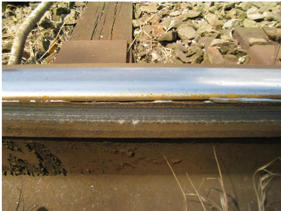
Figuur 3. Foto van uitbrokkeling tong in Zeeuws Vlaanderen.
