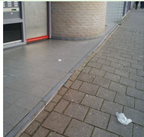
Ophoging van de stoep bij de entree van het complex
