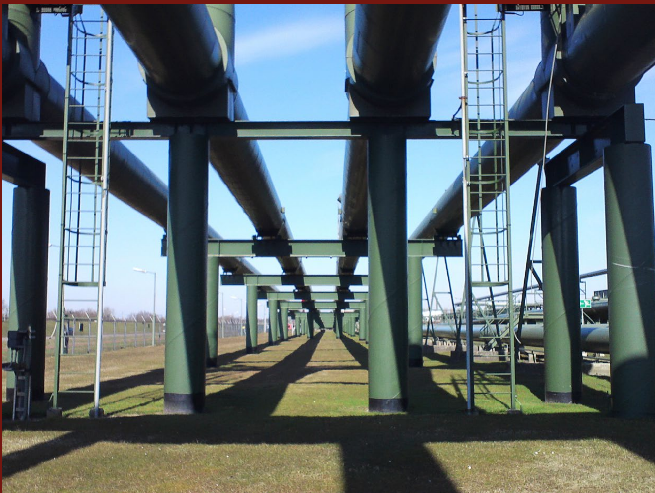
Leidingbrug Den Helder (foto SodM)
