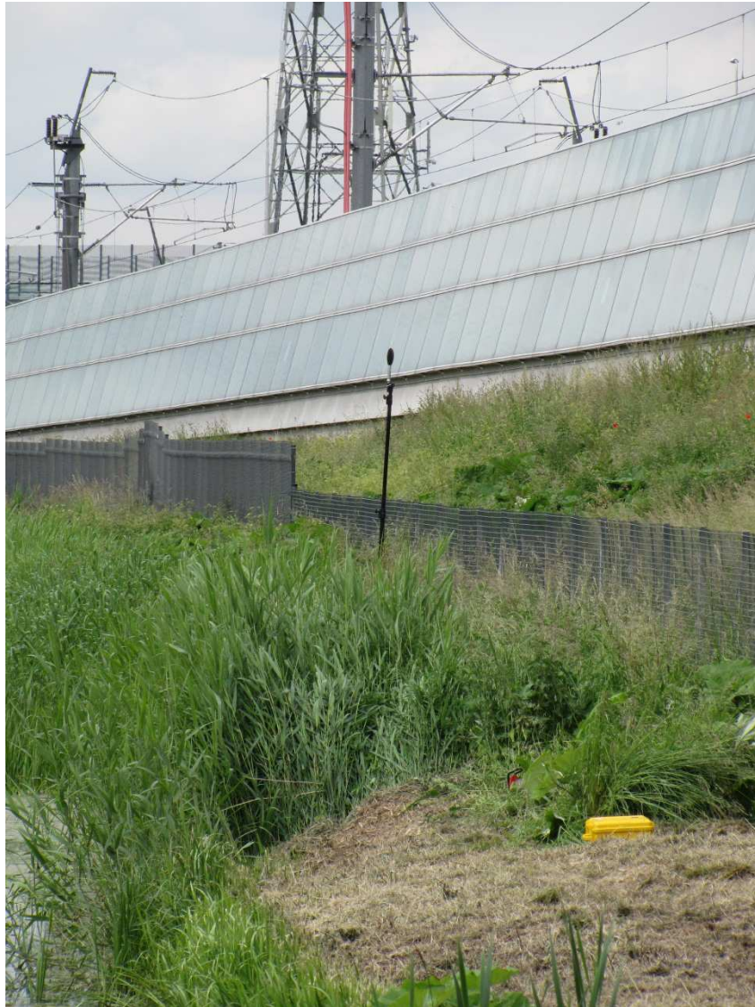
Figuur 5 Overzicht van het HSL spoor bij de woning aan de Boskade 10B met 1 van de twee microfoons om de snelheid te bepalen.
