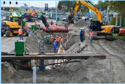
Omschakelen van oude naar nieuwe leiding
