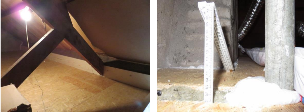
Figuur 68: Zoldervloer woning 194
