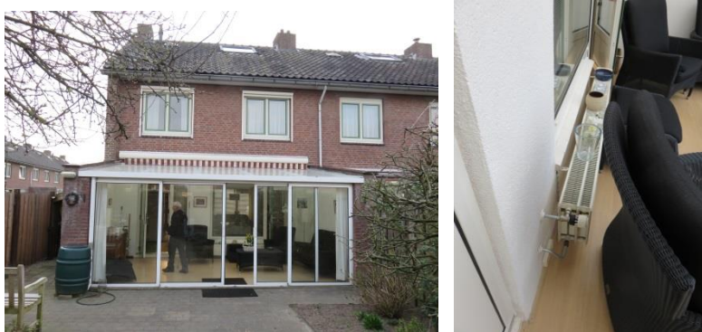
Figuur 42: Serre/uitbouw woning 127
