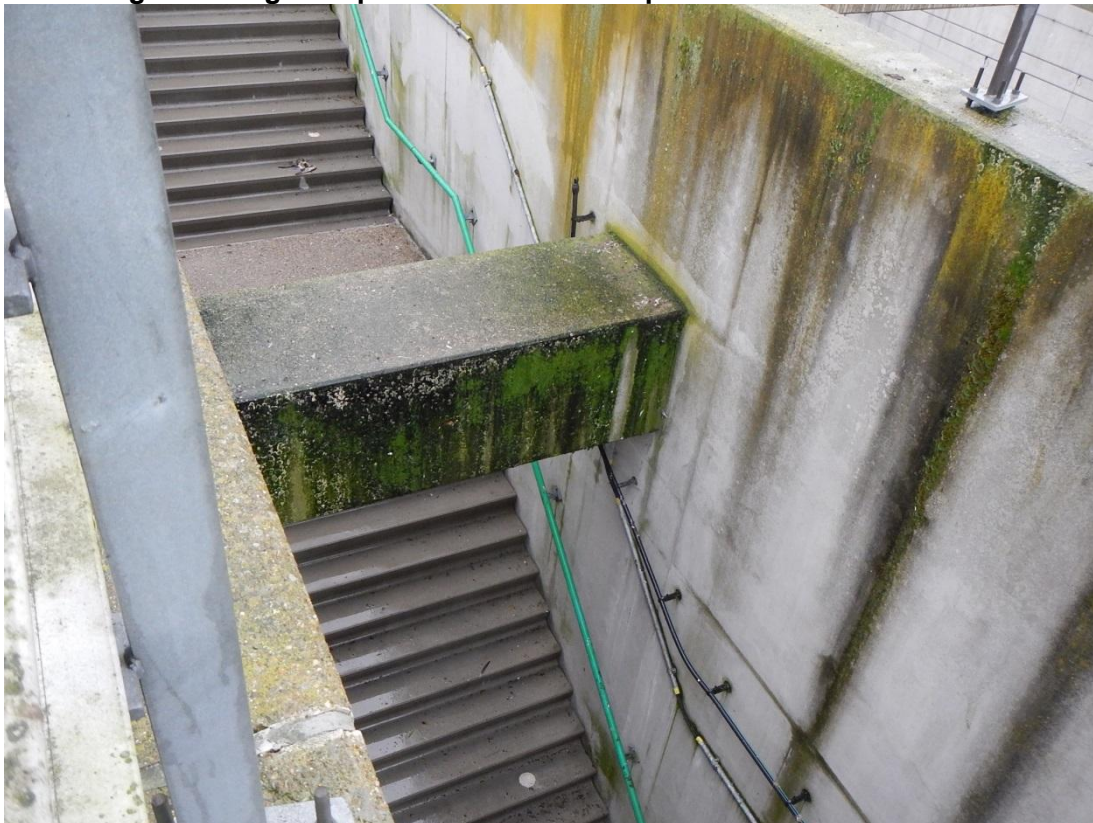
Afbeelding 6.1. Mosgroei op onbehandelde stempel
