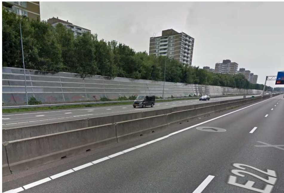
Figuur 1 Voorbeeld: A10-west, voor sanering bij hoogbouw zijn hogere schermen doelmatig
