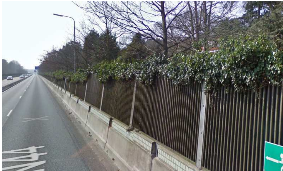
Figuur 10 Voorbeeld: Geluidscherm op barrier
