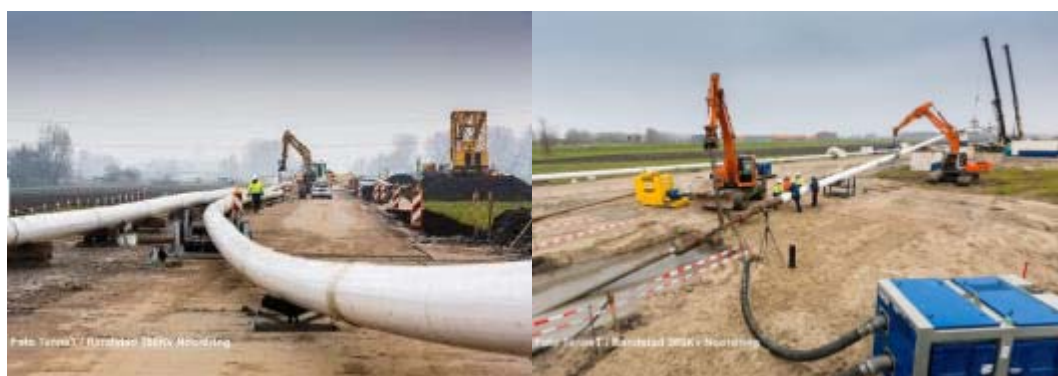
Figuur 17: Boring Randstad 380 kV
