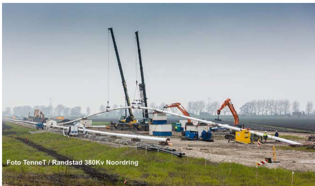
Figuur 5: Boring 2 circuits 380 kV
