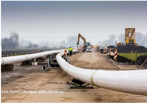
Figuur 6 Boring 2 circuits 380 kV
