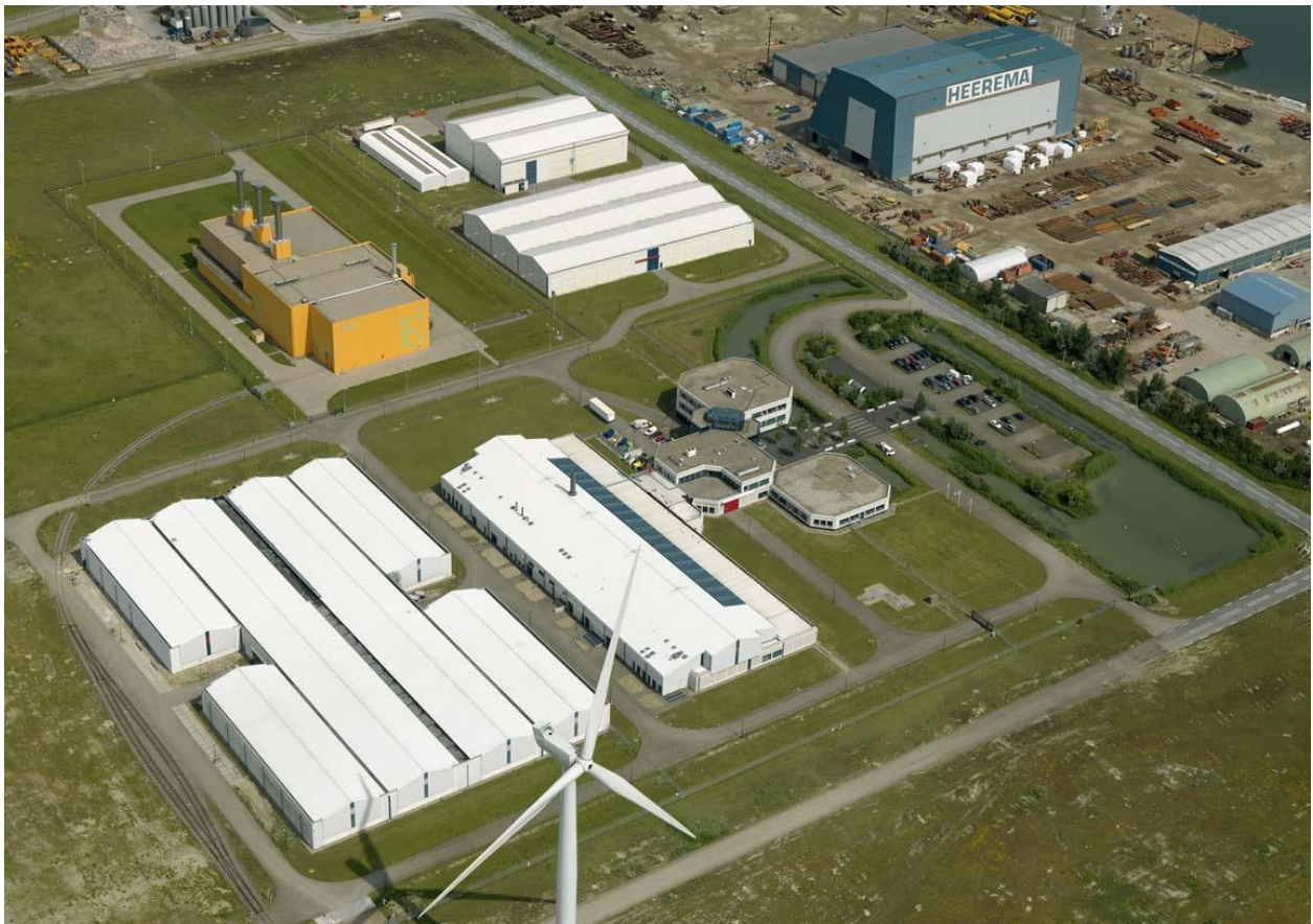
Figuur D.1 Terrein van COVRA (situatie vanaf 2010).
