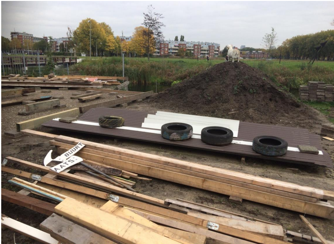
Organische gebiedsontwikkeling: het nieuwe onderkomen van de Buurtwerkplaats in aanbouw.
