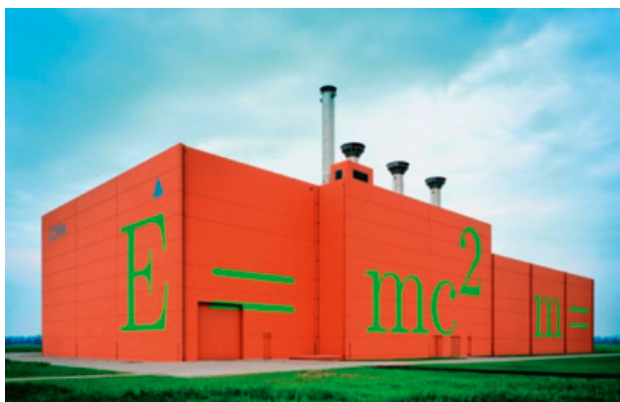
Figuur D.3 Het HABOG – de buitenkant.
