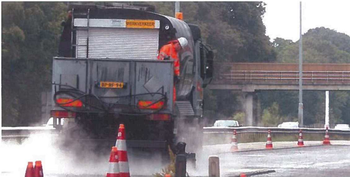
Figuur 9.1 Nieuwe asfaltoverlaging
