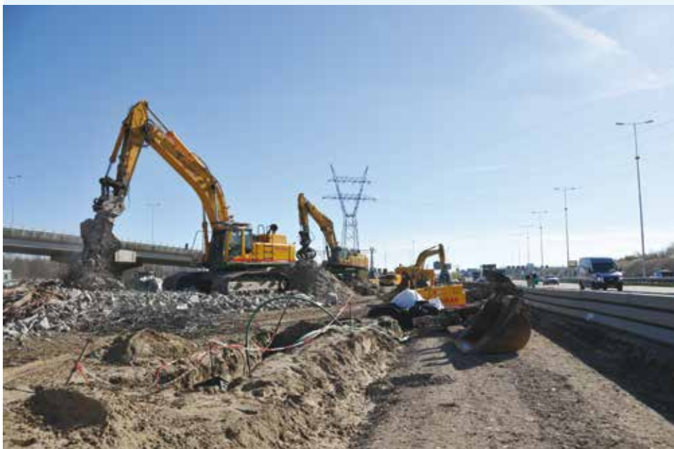
De doorstroming en de veiligheid van de A15 zijn verbeterd door de aanleg van extra rijstroken. (BRON: MAASVLAKTE2.COM)
